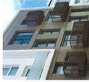
garde corps à barreudage et "ruban" béton
