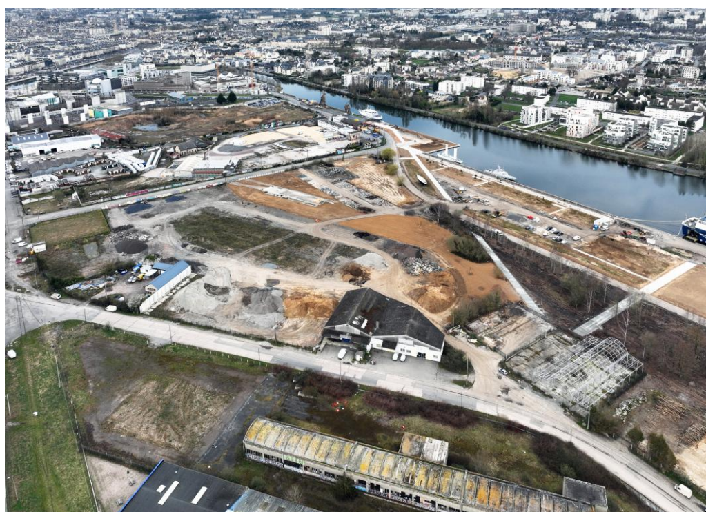
Le site après déblaiement des sols pollués.
